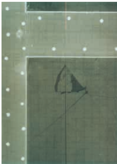
6. Eremu beraren erradiografia. Arraildurak eta pitzadurak. / Radiografía de la misma zona. Grietas y fisuras.
